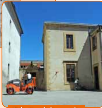
Réfection de la cour de récréation de l'école Saint-Alary
