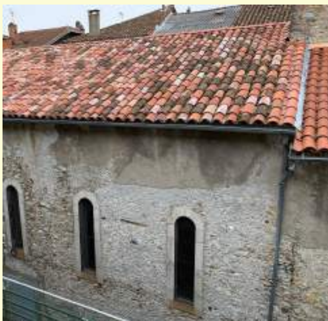
Réfection de la toiture de la Chapelle Sainte-Virginie
